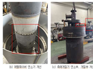
〈50 Nm³-biogas/hr급 수소개질 장치 설비 개선〉
