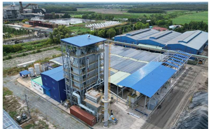
[미활용 바이오매스 플랜트 전경]
