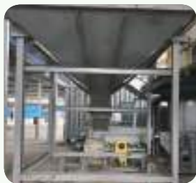
왕겨펠릿 투입용 호퍼 설치
